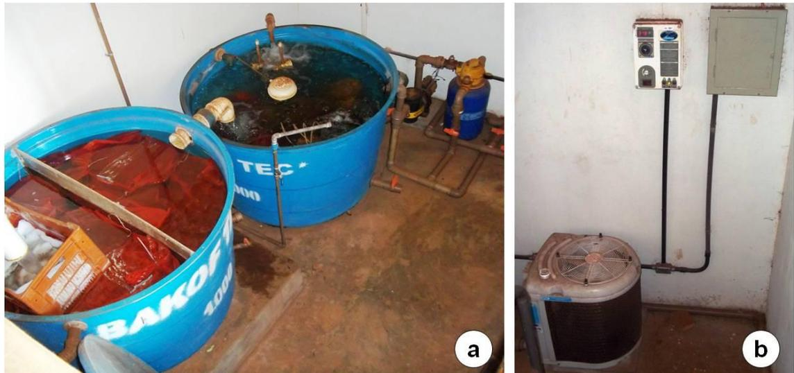
**Figura 3.** Sistema de recirculação de água para abastecimento dos tanques. Biofiltro mecânico e biológico (a). Trocador de calor para o controle de temperatura, com termostato digital (b).
